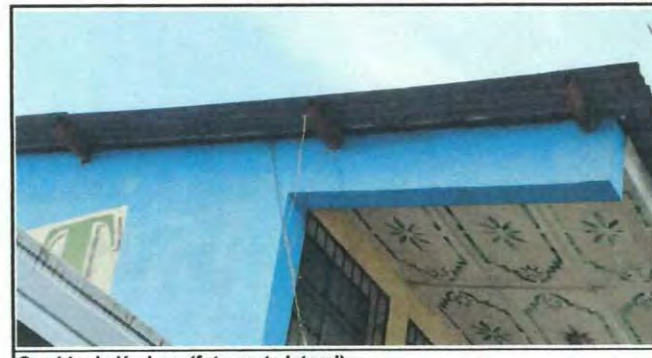
Cambio de láminas (foto parte lateral)
