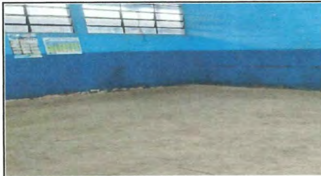
Aula donde se intalará pisos
