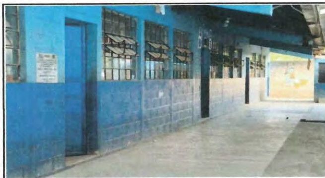
Mantenimiento, colocacion de chapas y cambio de abatimiento de las cuatro puertas, (modulos de Aulas de Proase)
